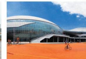
支持云南曲靖体育馆建设
